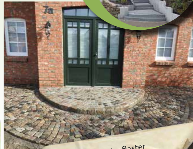
Bunt-Kleinpflaster in Splitt gesetzt
